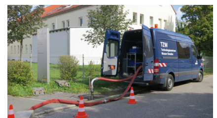
Rohrnetzspülung in Prof.-Röntgen-Straße
