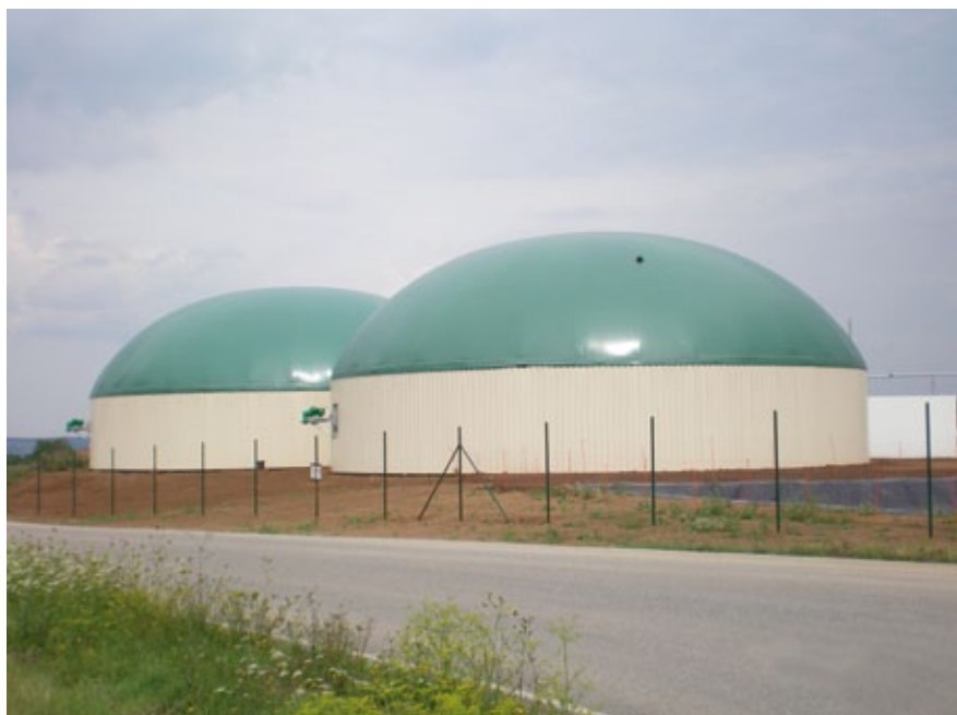
Biogasanlage in Flemmingen
