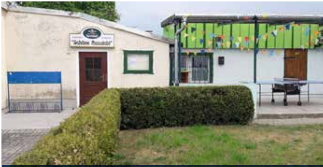
Dank des Sponsorings der TWN erhält die Fassade einen neuen Anstrich
